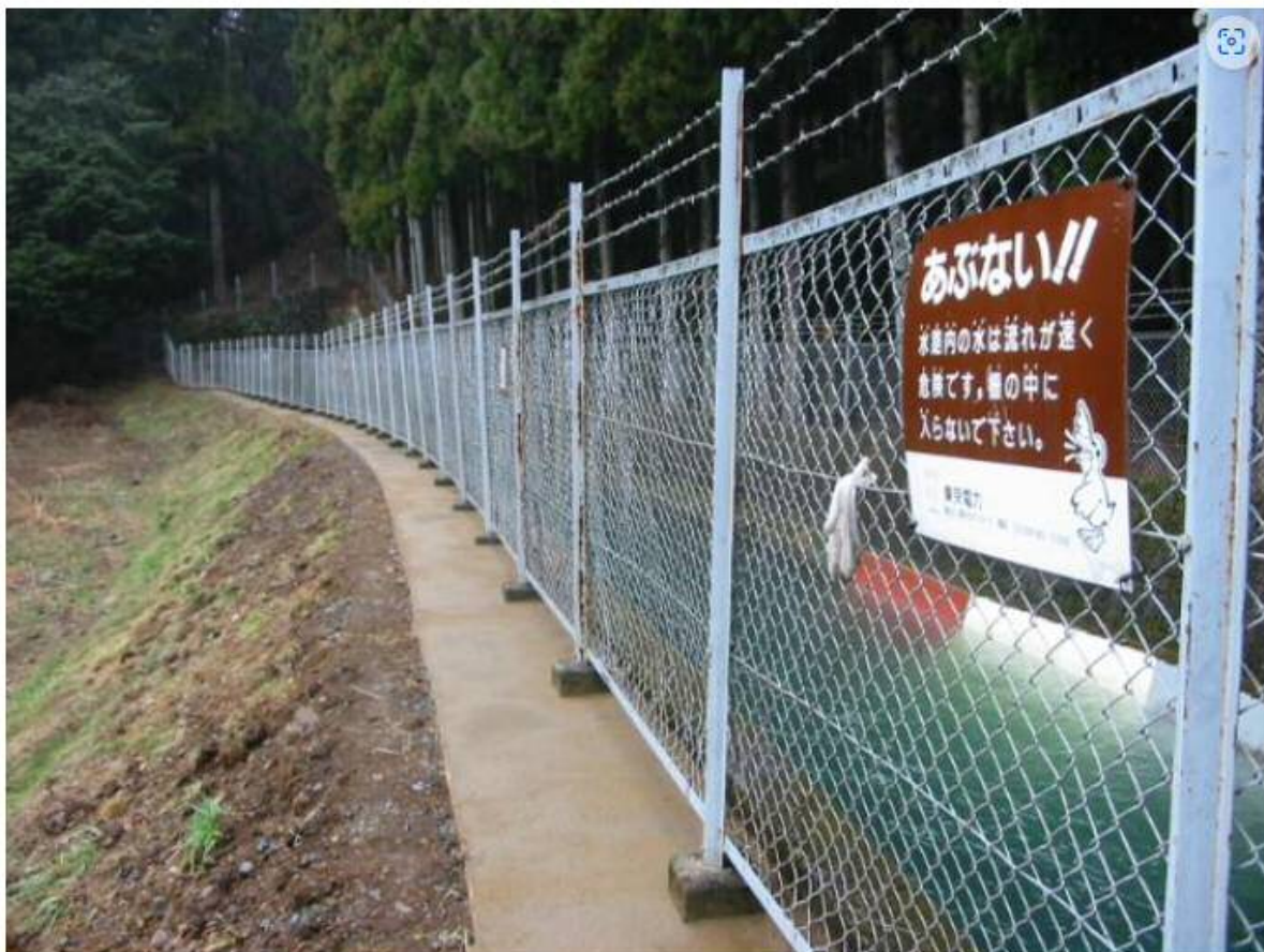
フェンス下の防草対策【透塊ソイル】で施工しました
