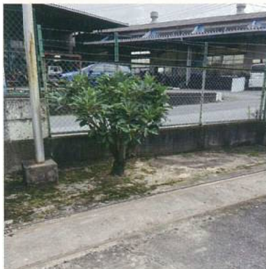
12年前施工 植樹回り ソイル40m/m
