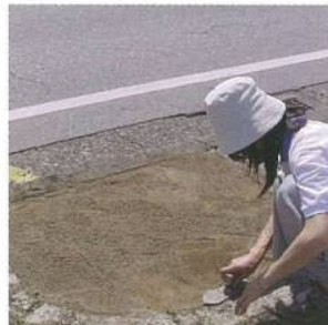
03. 材料敷き均し・転圧
