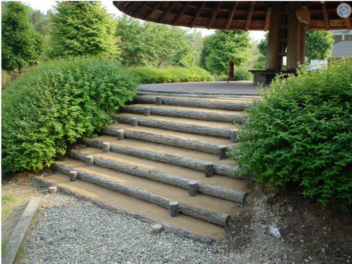
公園の階段を【透塊ソイル】で施工
